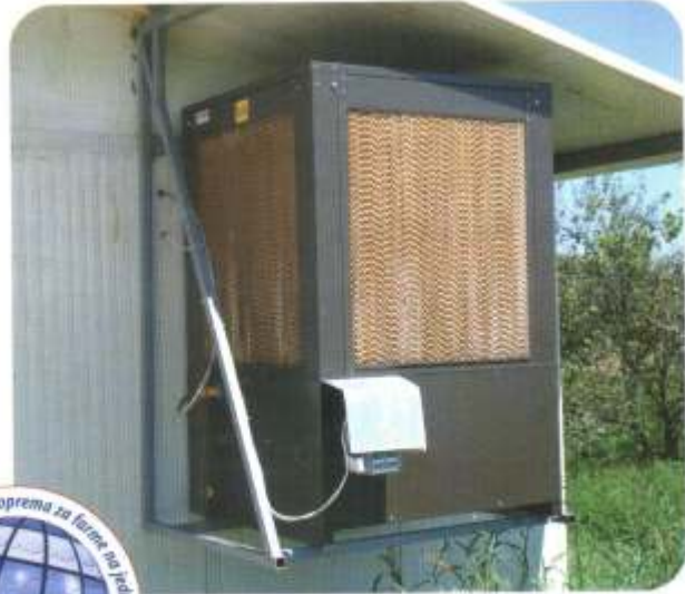
Mobilni rashladni uređaj ugrađen na farmi
